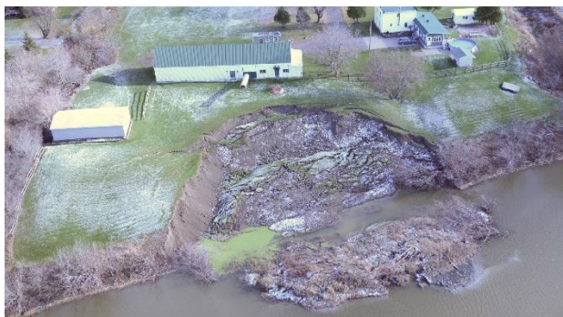
Figure 5. Exemple d'un glissement rotationnel profond de novembre 2017 et situé à l'intérieur d'un grand méandre d'une rivière au sud du St-Laurent, (source : MTQ).
