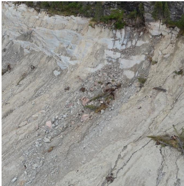
Figure 12. Accumulation de blocs dans le flanc de la portion nord-est de la cicatrice, associée à la chute de blocs des parois rocheuses sus-jacentes.
