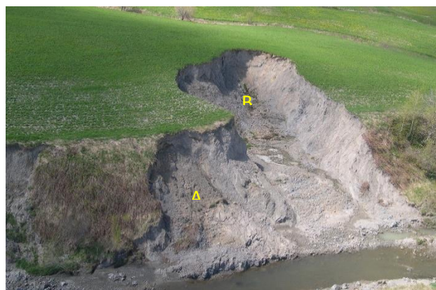
Figure 9. Exemple d'un glissement rotationnel simple (A) et d'une petite coulée argileuse (B), tous deux déclenchés par l'érosion causée par un cours d'eau au pied des talus (source : MTQ, 2008).
