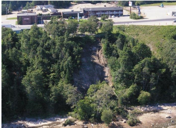
Figure 5. Exemple d'un glissement superficiel aux Escoumins en 2008.
