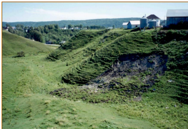
Figure 4. Exemple d'un glissement superficiel survenu lors des pluies extrêmes de juillet 1996 à Hébertville. À noter l'absence d'érosion au pied du talus (source MTQ).
