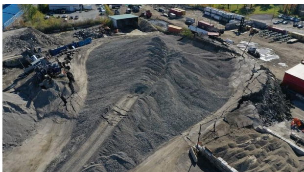
Figure 8. Vue générale prise par drone qui permet de bien visualiser la double rupture d'un remblai de granulat (Vaudreuil-Dorion, 9 octobre 2019).
