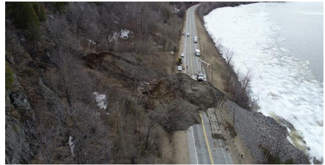
Figure 5. Vue d'ensemble prise par drone d'un glissement de terrain (Grande-Pile, 13 avril 2020).
