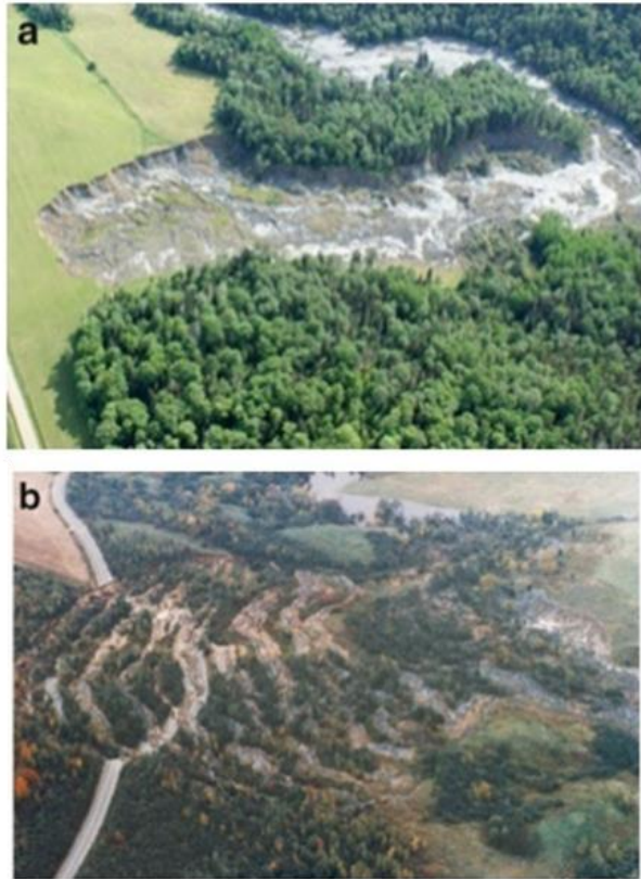
Figure 6. Exemples des deux principaux types de glissements de terrain fortement rétrogressifs dans les argiles sensibles. En (a), une coulée argileuse (Notre-Dame-de-la-Salette, 2010); et en (b), un étalement (Saint-Luc-de-Vincennes, 1986).
