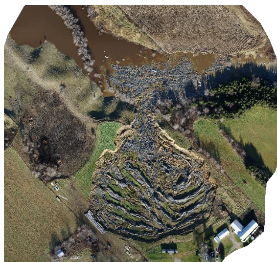
Figure 9. Orthomosaïque constituée de photographies aériennes qui montre un glissement de terrain fortement rétrogressif à Saint-Luc-de-Vincennes (Tremblay-Auger et al., 2020). Relevés réalisés par drone le 11 novembre 2016.
