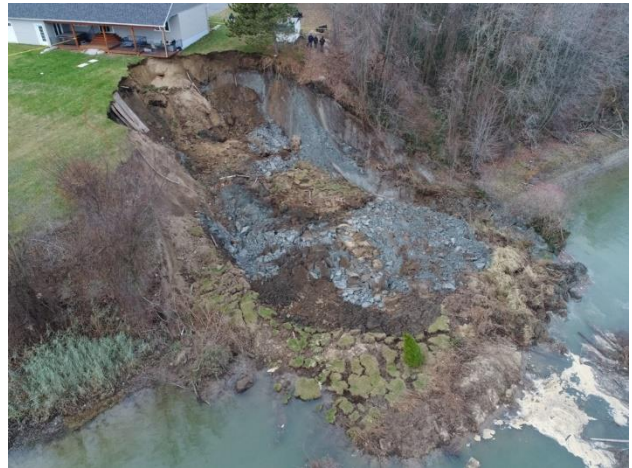
Figure 5. Exemple d'un glissement rotationnel dans des sols argileux (source : MTQ, 2017).
