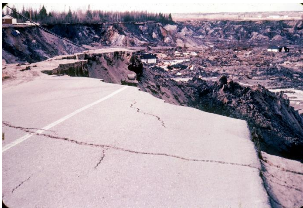
Figure 2. Vue générale du glissement de Saint-Jean-Vianney (Source : Ministère des Transports)
