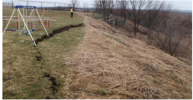
Figure 3. Exemple d'une fissure avec déplacement vertical au sommet d'un talus argileux, faisant partie de la classe des « amorces » de glissement de terrain (source : MTQ, 2008).
