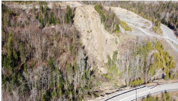
Figure 2. Observations réalisées par drone sans s'exposer au danger, soit en demeurant à l'arrière d'un ouvrage de protection temporaire mise en place en pied de talus (Matane, 1 er mai 2021).
