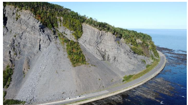
Figure 6. Vue générale prise par drone d'une rupture dans le roc à Mont-Saint-Pierre (été 2021) et du talus d'éboulis particulièrement volumineux à cet endroit.
