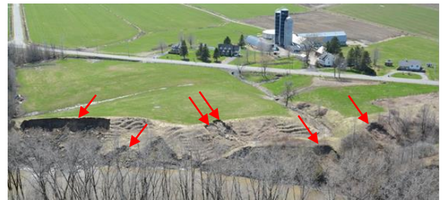
Figure 2. Exemples de glissements de terrain en bordure de la rivière Sainte-Anne, près de Sainte-Anne-de-la-Pérade, survenus au printemps 2017 et qui n'ont pas fait l'objet d'un signalement auprès des autorités gouvernementales (source : Photo MTQ).
