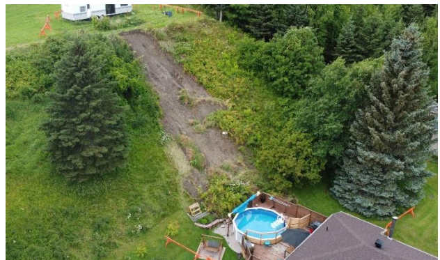
Figure 4. Exemple d'un glissement de type superficiel (source : MTQ, 2021).
