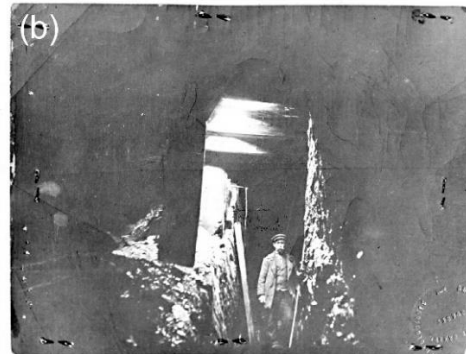
vue dans la roche sous la terrasse Dufferin. M. Turmel
