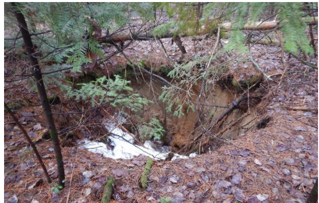
Figure 5 : Exemple d'une cavité formée par suffosion ayant un diamètre de 3 m et une profondeur de 1.5 à 2 m (Source : MTQ).
